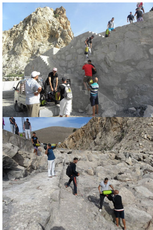
Chaîne logistique sur la digue du port
